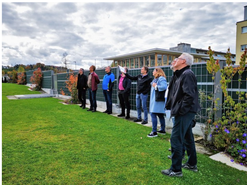
Wald- und Liegenschaftsbegehung 2020 Lärmschutzwand Warteggweg 24/24a
