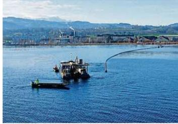
Insgesamt werden 700 Meter Rohrstränge von der Seethermie-Energiezentrale in Horn in den See führen, 230 davon unterirdisch. Bildquelle: z.V.g.
