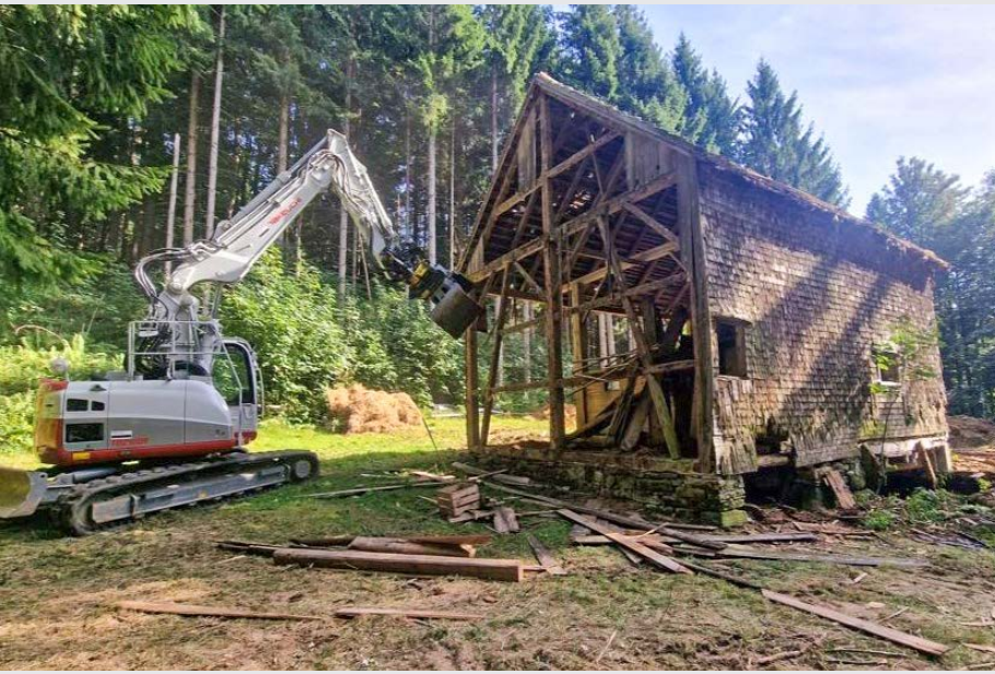
Abbruch Weidscheune in Eggersriet
