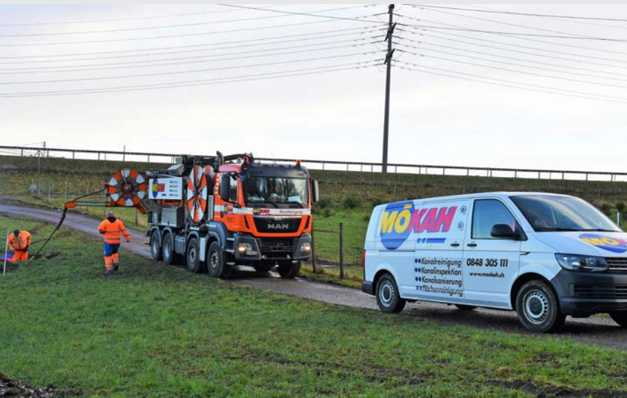
Kanal-TV-Aufnahmen und Spülung der Leitungen auf Grundstück Nr. 571
