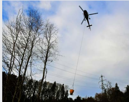
Betonlieferung für die Hängebrücke im Rantelwald
