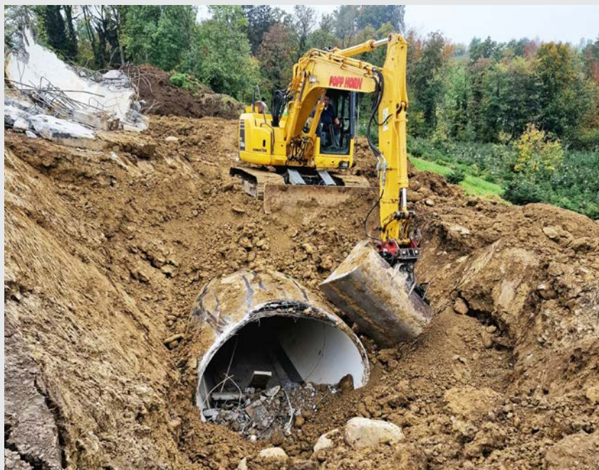
Rückbau militärische Anlage auf dem Areal Mühlegut
