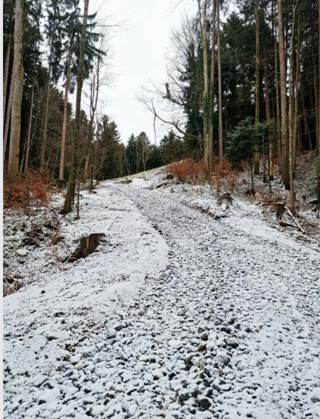
Erschliessungsstrasse in Eggersriet
