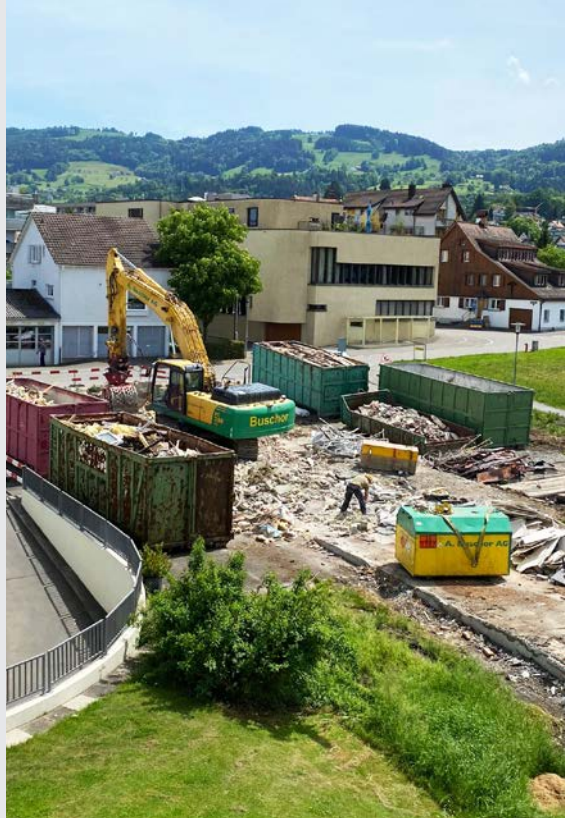
Abbruch EFH und Anbauten am Warteggweg 26
