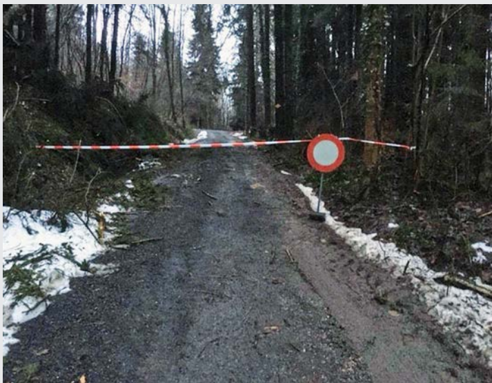
Schäden an Rantelstrasse 31.01.2021
